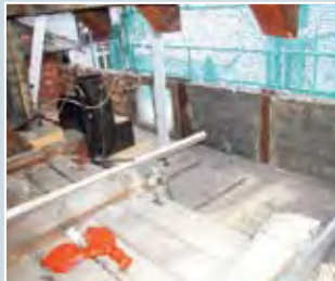
4. Innenansicht mit geöffnetem Boden und ausgeschnittenem Dach für den Balkonausgang.
