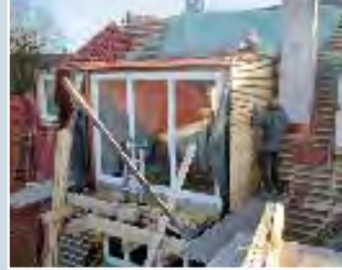
2. Dachelement als Zugang zum Balkon, auf der dem Münster abgewandten Seite.
