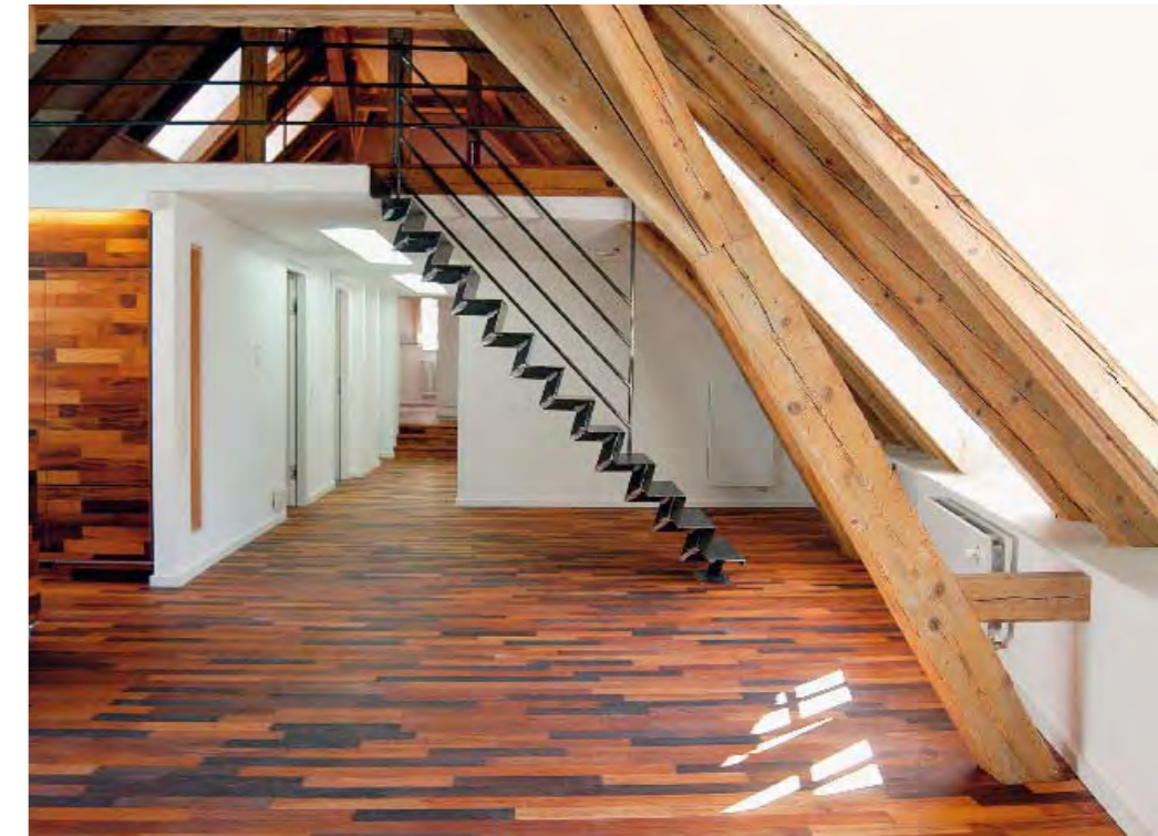
Eine offene naturbelassene Stahltreppe führt als gefaltete Stahlplatte zur Galerie hinauf.
