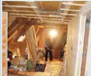
5. Unterkonstruktionen für Wand und Decke. Mit Ausschnitt für indirekte Beleuchtung.
