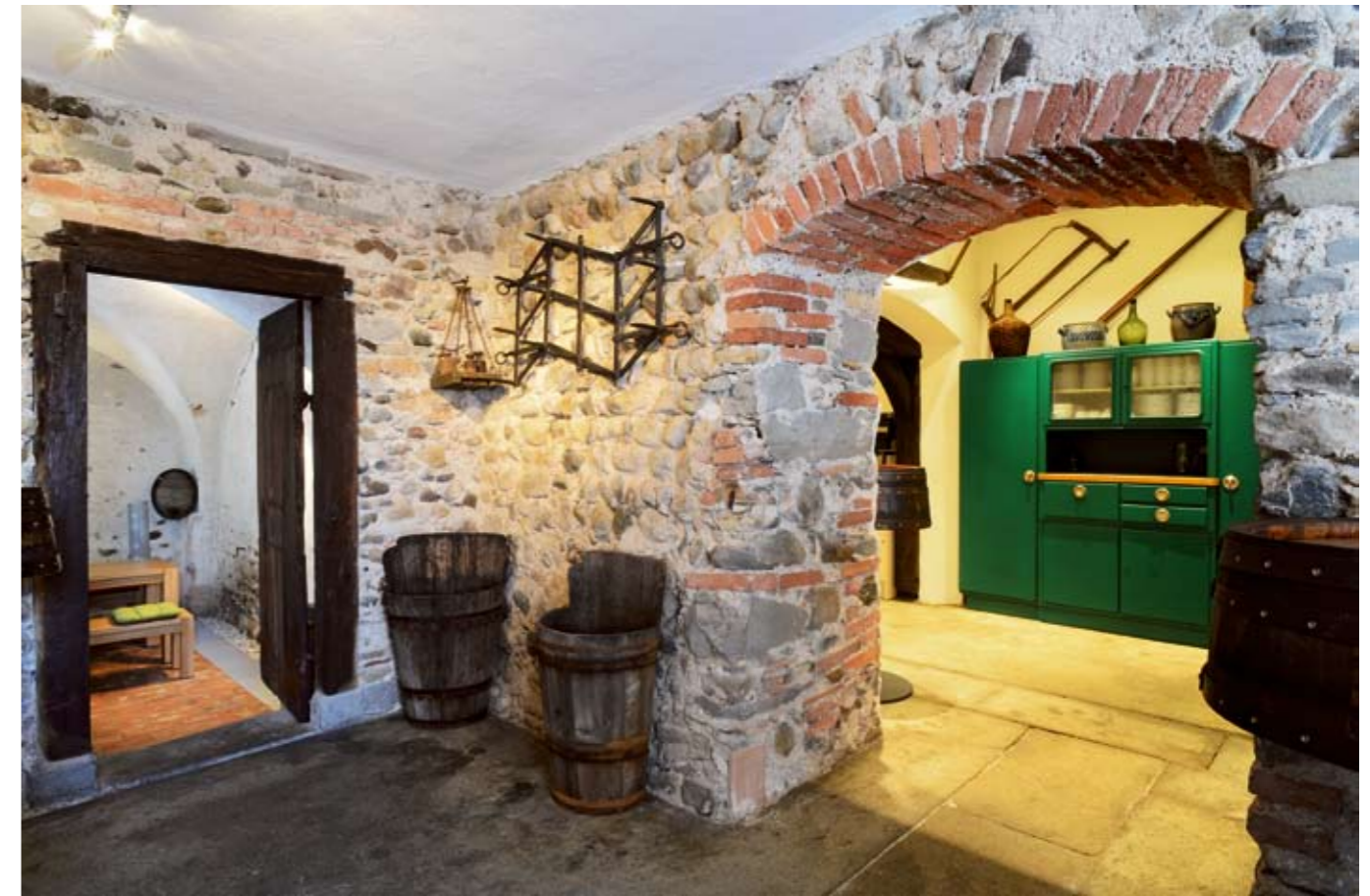
Das massive Mauerwerk wurde fachgerecht freigelegt und bezeugt die bauliche Fertigkeit damaliger Insel-Baumeister. Beim historischen Mauerputz Pietra-rasa blieben nur die Steinköpfe sichtbar, Lüftungsschlitze bringen Warmluft in den Keller.
