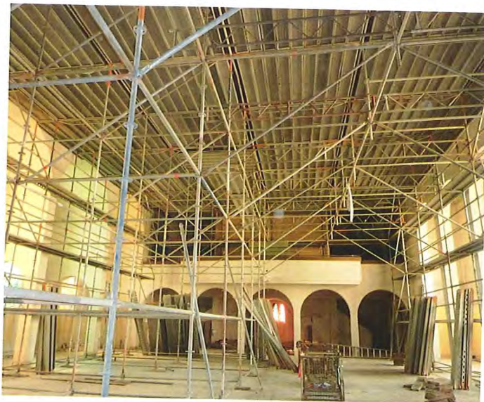
Der Kirchenraum ist eingerüstet. Hier Untersicht der begehbaren Arbeitsfläche für die Restaurierung der Originaldecke
