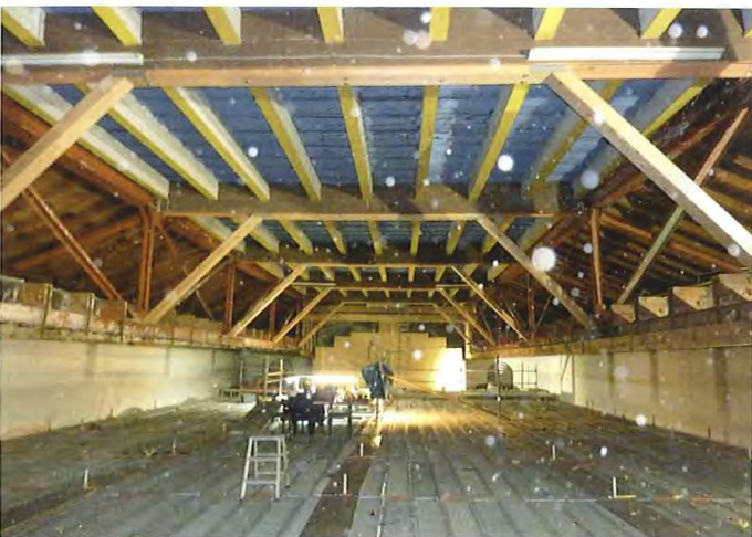
Blick auf die freigelegte Linder Decke vor der Restaurierung
